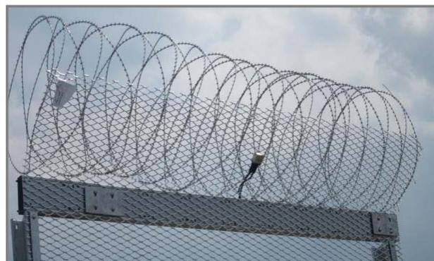
Abb.3: Flexibler Übersteigschutz mit SZ-Super-Drahtrolle auf Zaunelement
