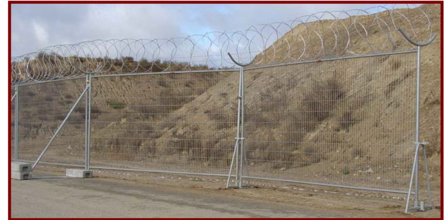
Übergang Ausführungsvariante 3) befestigte Oberfläche - zu Ausführung 1) unbefestigte Untergründe
