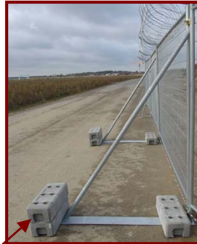
Übergang Ausführungsvariante 3) befestigte Oberfläche - zu Ausführung 1) unbefestigte Untergründe
